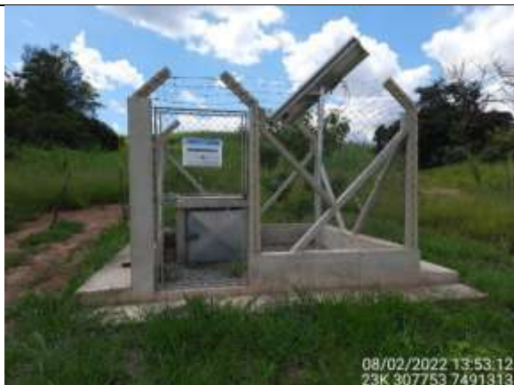
Foto 1 – Vista da estrutura de proteção para a estação sismográfica (08/02/2022).
