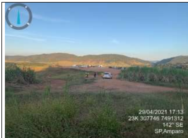
Foto 1 – Local da instalação da EMA no canteiro industrial da Barragem Duas Pontes.
